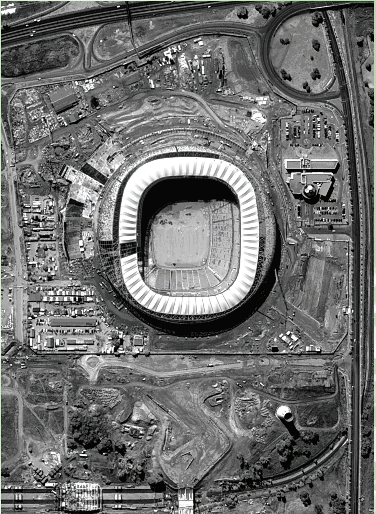
南非世界杯足球场—建设中 拍摄日期：2009年5月6日
